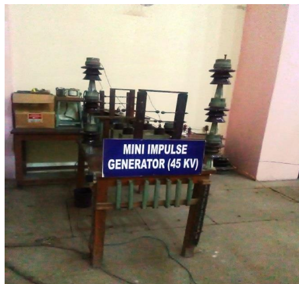
Figure 3: Mini Impulse Generator (45KV)
